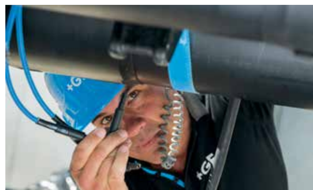
Connecter les câbles de soudage aux contacts de soudage du raccord et souder selon le manuel d'instructions.
