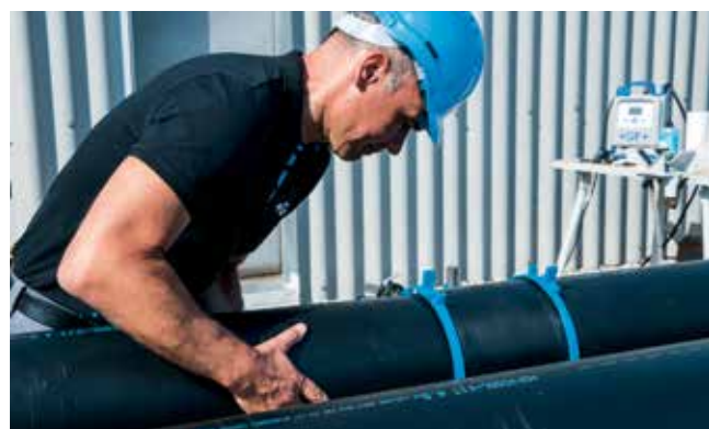
Faire glisser les deux extrémités du tuyau dans le raccord jusqu'à la marque. Retirer ensuite la bande à l'assemblage.
