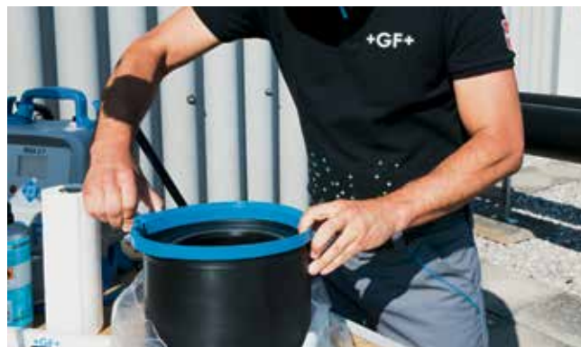
Placer la bande au montage sur le raccord. Étirer la levre d'étanchéité en pressant les poignées l'une contre l'autre.
