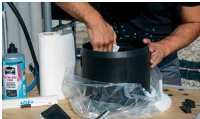
Nettoyer les zones de fusion du raccord et du tube avec le nettoyant Tangit PE et un essuie-tout propre.
